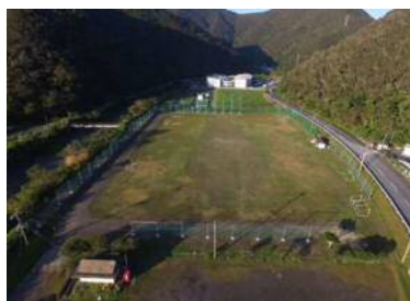
サッカー場防球フェンス設置工事
