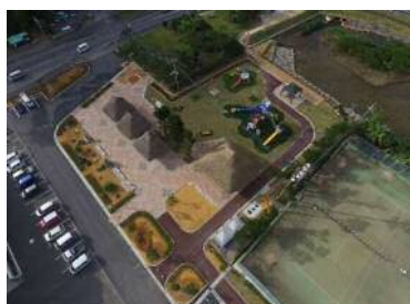
公園整備工事
