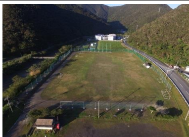
サッカー場防球フェンス設置工事
